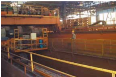
Meishan Steel and Iron Plant, Nanjing in China, Crane, lots of dust, high speed. Meishan Stahl- und Eisenwerk, Nanjing in China. Kran, viel Staub, hohes Tempo.
