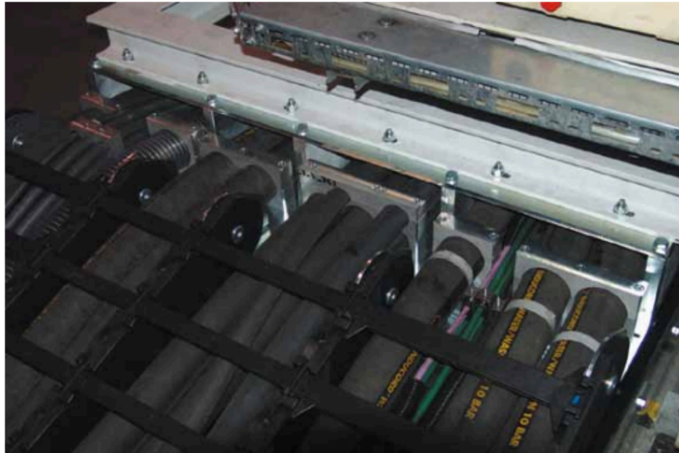
High additional load due to high numbers of hoses and cables Hohe Zusatzlasten durch Schläuche und Kabel
